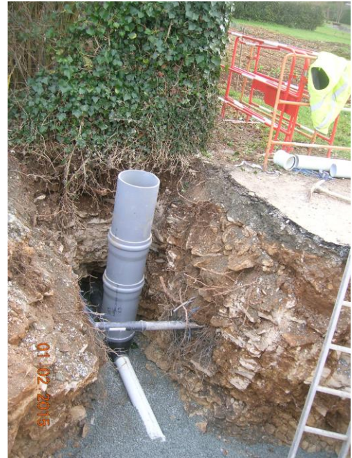
Figure 4 : réalisation d'un branchement
