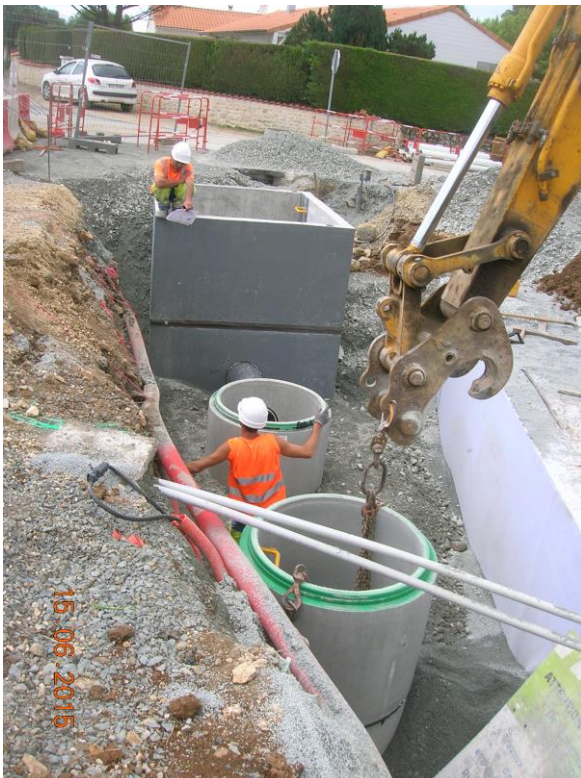
Figure 8 : pose d'un réseau eaux pluviales
