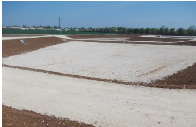
Figure 7 : terrassements d'un bassin d'orage
