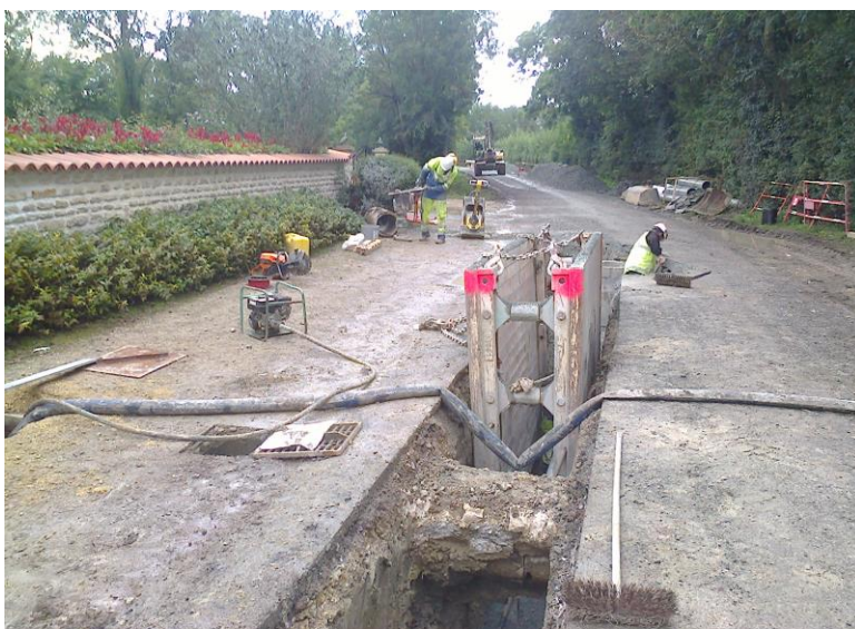
Figure 6 : pose d'un réseau EU avec blindage
