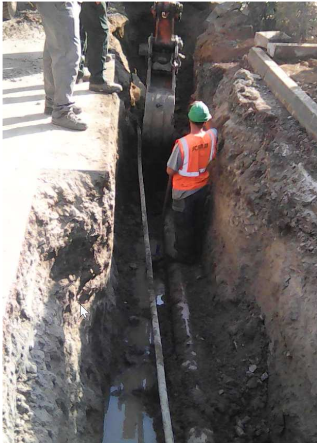
Figure 6 : renouvellement de réseau – la Tranchée (Niort)
