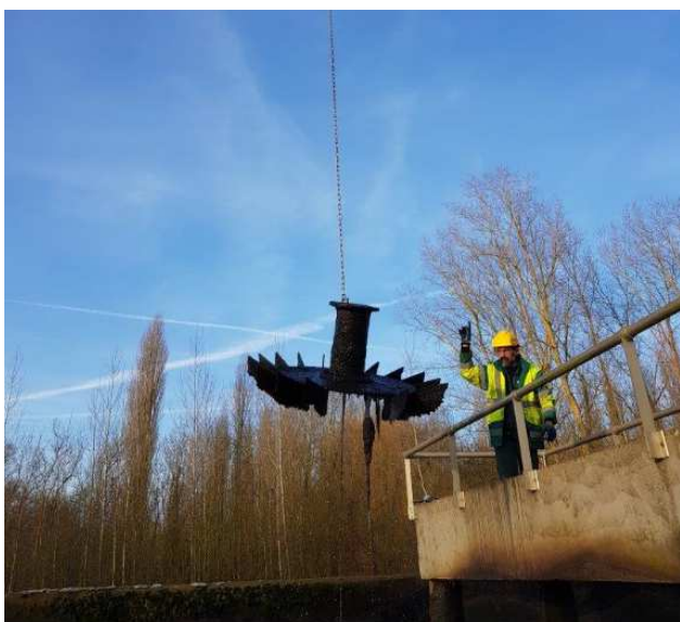
Remplacement d'un rotor par un rotor haut rendement, STEP Magné -
