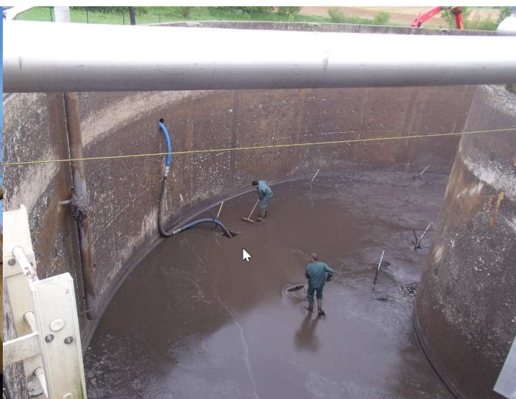
Renouvellement des diffuseurs fines bulles de la STEP de Pelle-Chat
