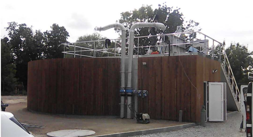
Figure 5 : travaux Bassin Tampon Aiffres
