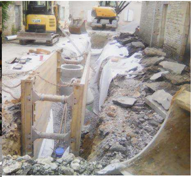
Extension de réseau eaux usées (Le Vanneau Irleau – route de Niort)
