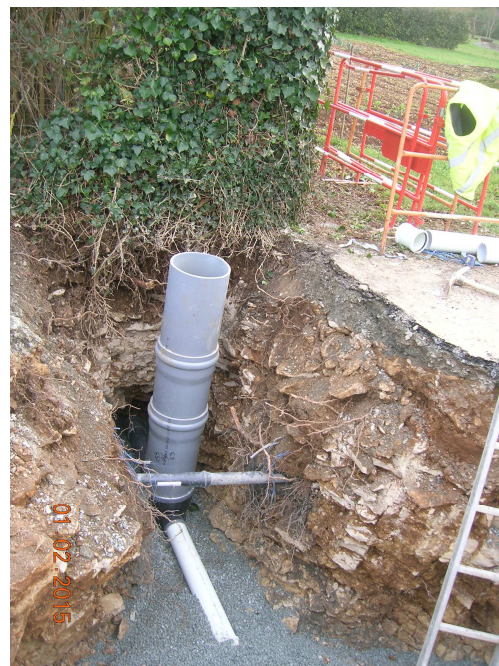
Figure 3 : réalisation d'un branchement
